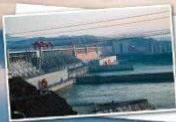
為了進一步開發長江水利資源，中國在宜昌市三斗坪建成超巨型的三峽水利樞紐工程。三峽工程由攔河大壩及洩洪建築物、水電站和通航建築物等部分組成。攔河大壩為混凝土重力壩，河床中部佈置洩洪壩段大壩。建成後，水位上升100公尺，高峽出平湖。
